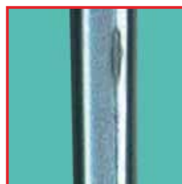
Corrosion de contact : acier inox / laiton
