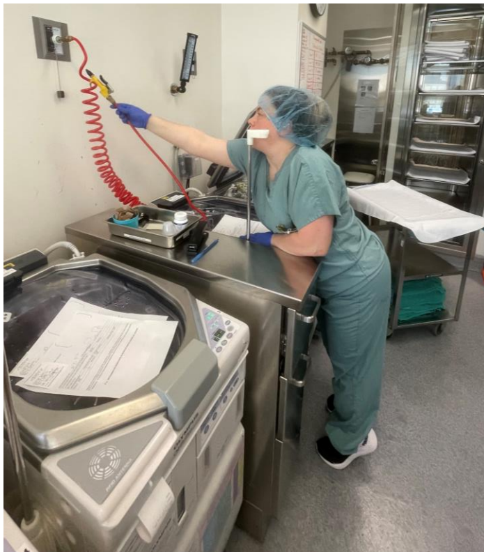
Source : Hôpital Pierre-Boucher
